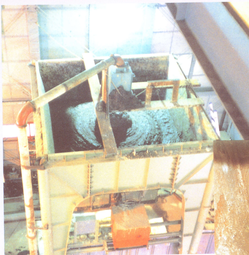
ポンプ圧送状況
